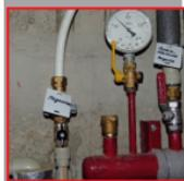
До начала розжига котла открыть линию подпитки системы отопления и контрольную линию заполнения расширительного бака. Убедиться, что давление по манометру, установленному на котле, не растёт.
